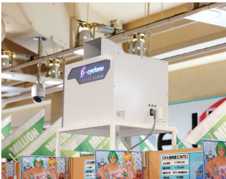
上部の大きな排出口から大量のマイナスイオンが放出される。フィルター部は左奥の側面に施されている
