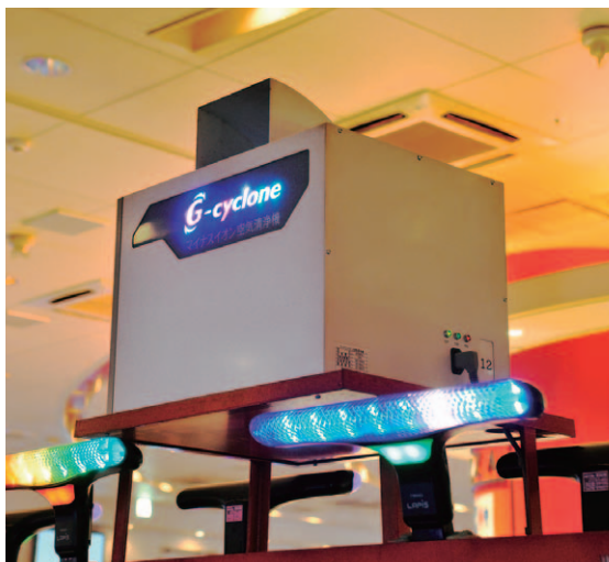
工事は簡単なので一晩で設置可能
